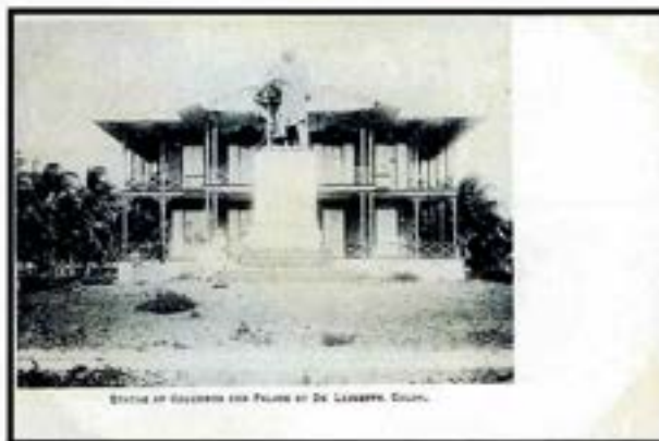
Fig. 12. De Lesseps' house in Colón.
